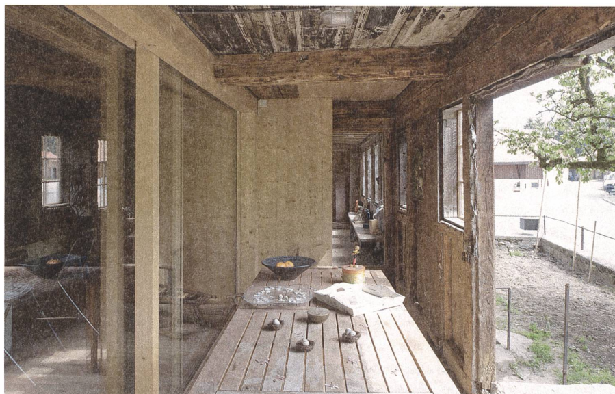
Fig. 4: Le retrait des volumes par rapport aux façades existantes dans une ferme transformée à Montécu permet l'amenée de lumière, une isolation thermique performante en conservant le caractère des façades. Il génère des espaces interstitiels de qualités, ouverts à diverses utilisations.
