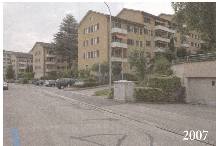
Abb. 3: Wohngebiet Kampstrasse, Blick nach Südosten: Siedlung der Gemeinnützigen Baugenos- senschaft Limmattal GLB.
