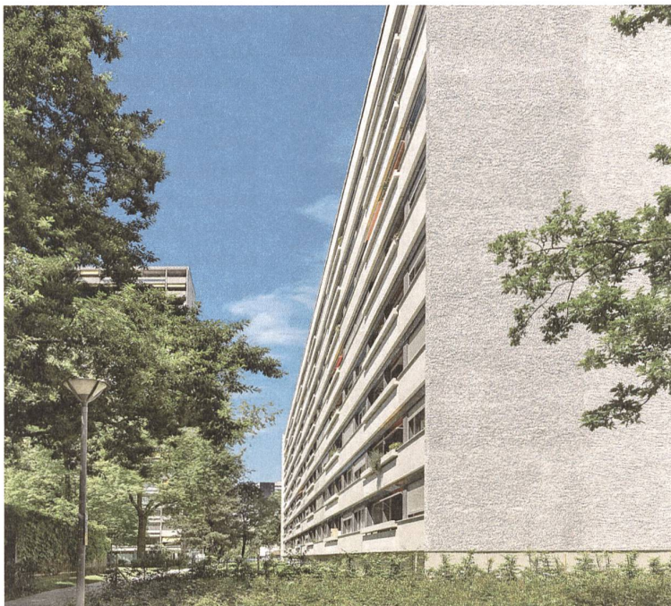
Abb. 6: Die angebaute, neue Raumschicht im Tscharnergut in Bern, Rolf Mühlethaler und GWJ.
