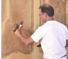
Aufmalen des Nussbaum-Maserbildes in den Füllungen. Ausgeführt mit Bierlasur und Zackenpinseln. Die Übergänge werden mit dem Dachshaarvertreiber verschlichtet.
