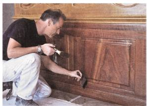
Letzter Öllasurauftrag im Hüfttäferbereich. Dieser ist farblich auf den Boden und das übrige massive Nussbaumholz abgestimmt. Im oberen Täferbereich fehlt dieser Auftrag noch.
