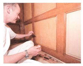
Holzimitationsmalerei von Eichenholz. Gestaltet mit helleren Füllungen und dunkleren Friesen, ausgeführt in Öltechnik.
