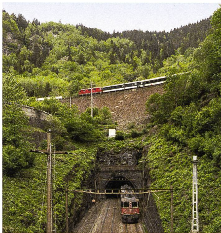
Der Freggio-Kehrtunnel ist einer der vier Kehrtunnels auf der Südseite Monte Piottinoschlucht. Damit konnten im engen Tal vor Ort zirka 80 Meter Höhe gewonnen werden.
