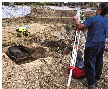
Arbeiten unter Zeitdruck. Tachymetrische Aufnahme eines frühmittelalterlichen Töpfersofens in Oberwil BL, 2013. Die Messungen werden direkt im CAD-System des Notebooks angezeigt.
