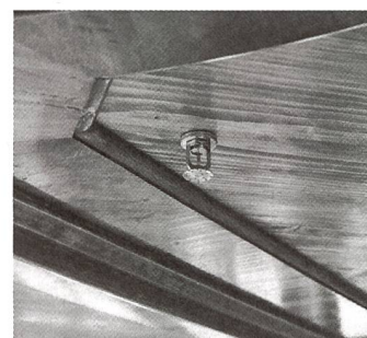
Die in die Holzdecke harmonisch integrierte Sprinkleranlage.
