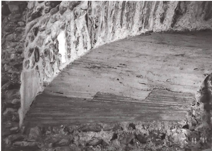
Ramosch (GR), Burgruine Tschanüff. Untersicht des ausgeschalteten Unterfangungsgewölbes. Unten das gestufte Widerlager aus Beton.
