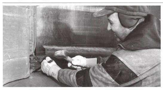
Eine neue Sohlbank aus dem Steinbruch bei Villarlod wird unter das Gewände eines Fensters eingepasst.
