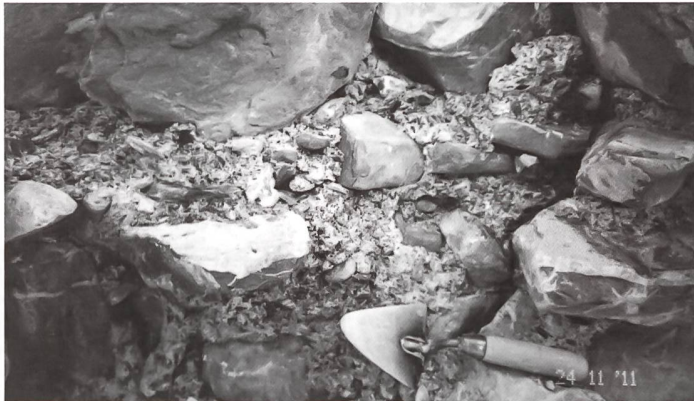
Attinghausen (UR), Burgturm. Blick in das Kernmauerwerk.
