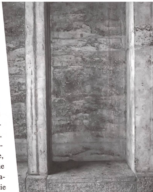
Der Originalbeton der Antoniuskirche zeigt grossflächig Kiesnester und offene Stellen.
