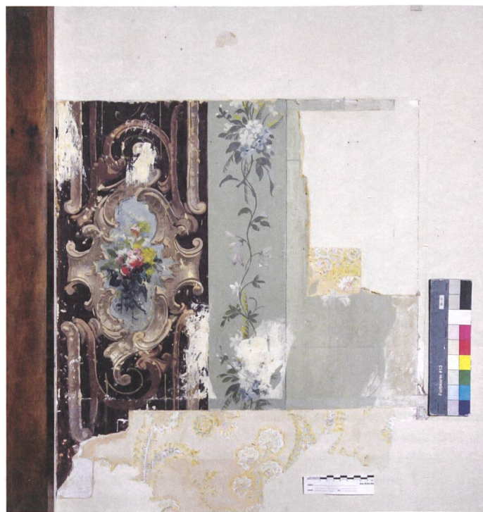
Überraschende Entdeckung: Freigelegte Ölmalereien an den Wänden des Damenzimmers.
