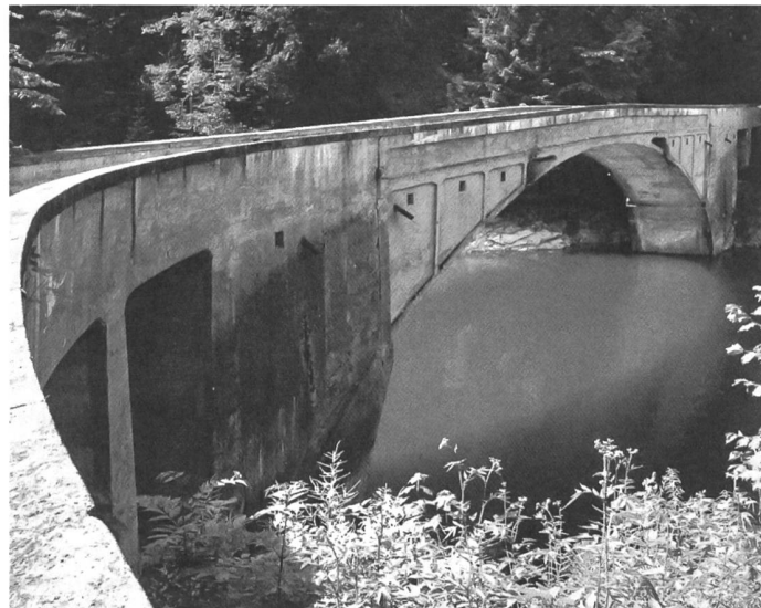
Schrähbachbrücke bei Innerthal im Wägital (SZ), 1924 von Robert Maillart erbaut; die vermutlich weltweit älteste noch erhaltene Brücke mit versteiftem Stabbogen.
