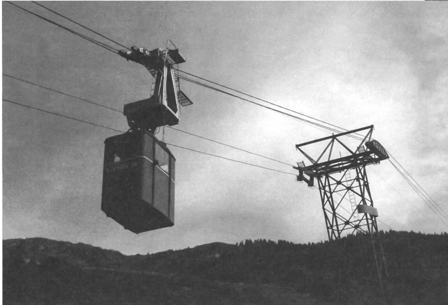
Kraftwerksbahn Rischinen – Massa, Bitsch (VS), von Kűpfer (1961). Fahrzeug mit Personenkabine; im Hintergrund Stahl-Fach- werkstütze mit asymmetrischen Stützenköpfen.
