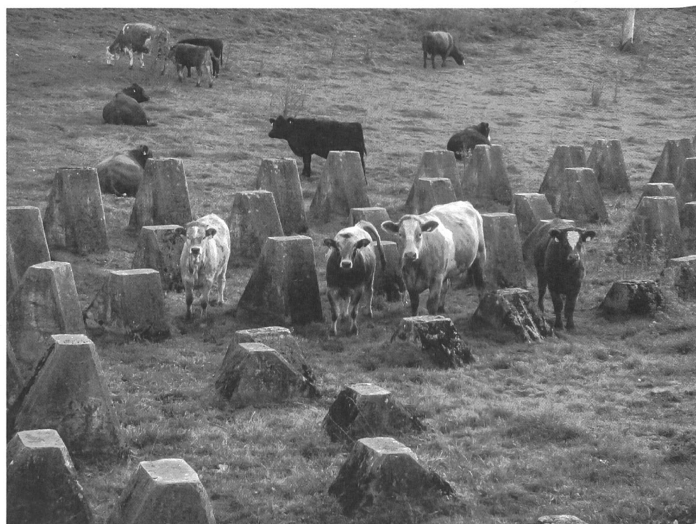
Obstacle antichars terrain type «toblerone» (Drachenzähne).
