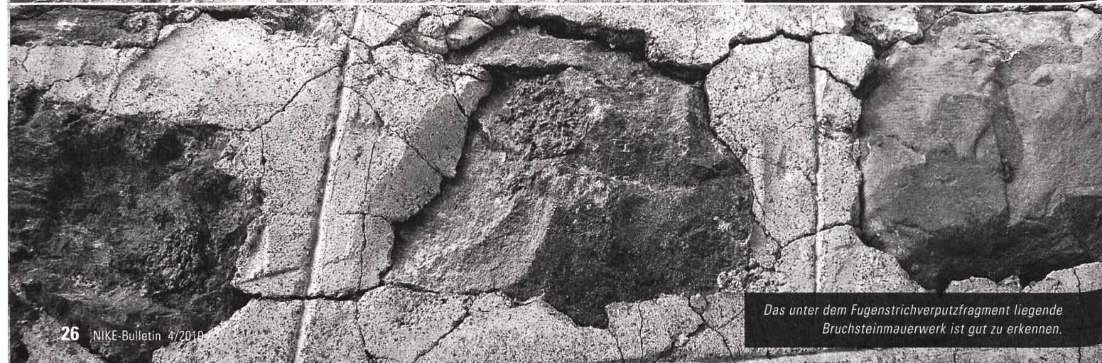
Eine grössere intakte Oberfläche mit Fugenstrichverputz am Pförtnerhaus/Pfarrhaus Hohenrain LU
