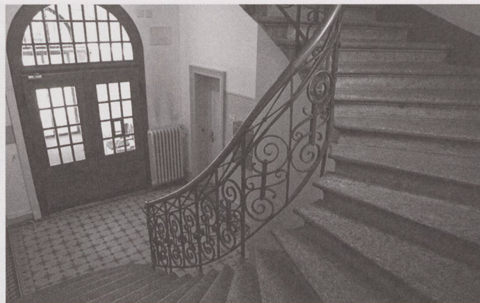
Erhaltenes Interieur: Zahlreiche Details zeugen von der hohen Qualität der Bauausstattung.
