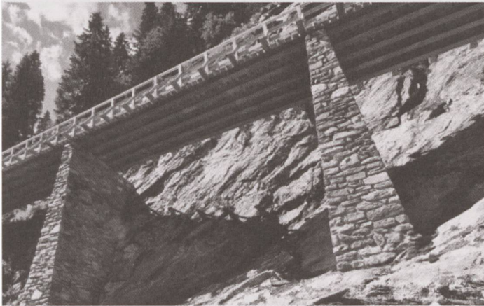
Die Starlera Brücke nach dem Wiederaufbau.
