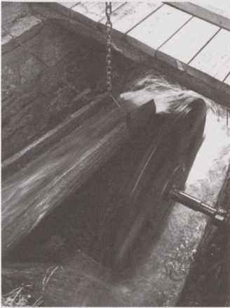
Ausserberg VS, Wasseranlagen der Undra-Suone.
