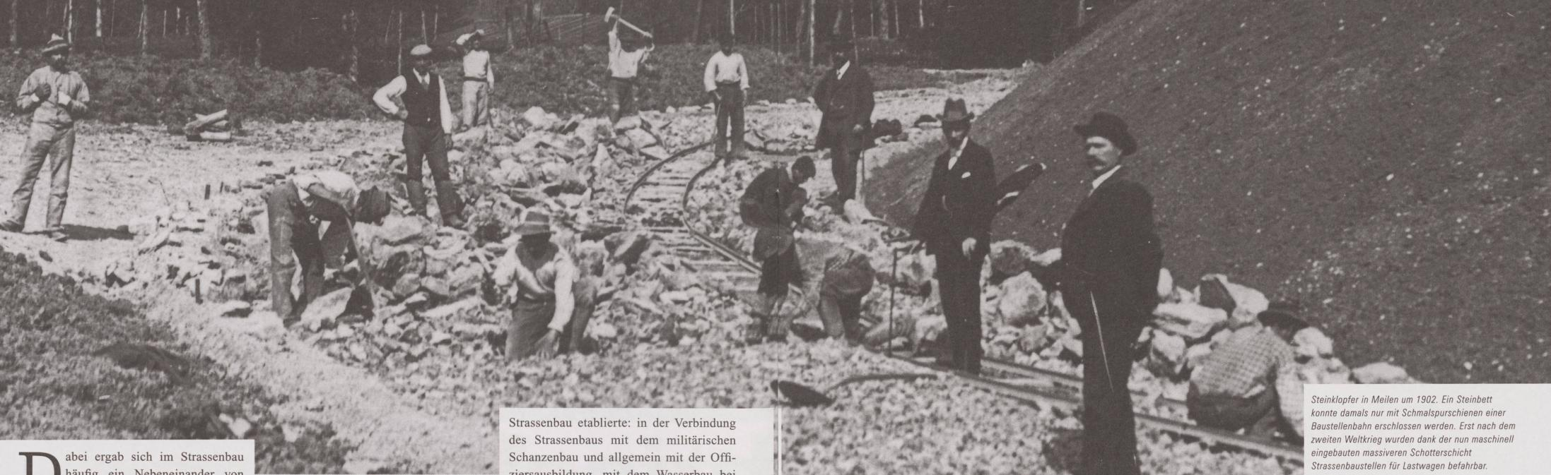
Steinklopfer in Meilen um 1902. Ein Steinbett konnte damals nur mit Schmalspurschienen einer Baustellenbahn erschlossen werden. Erst nach dem zweiten Weltkrieg wurden dank der nun maschinell eingebauten massiveren Schotterschicht Strassenbaustellen für Lastwagen befahrbar.
