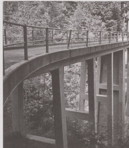
Kunstbaute: Die 1915 erbaute und 1998 sanierte «Scherenbrücke» bei Schindellegi SZ.
