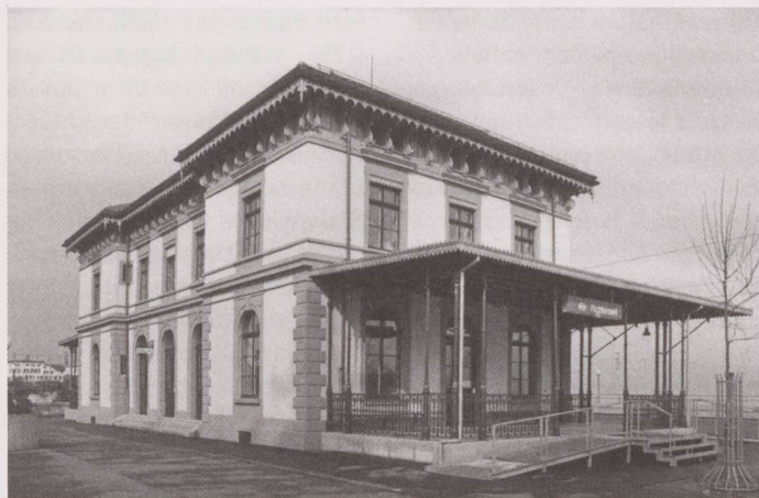
Die Sommerwertsäle am Bahnhof Richterswil sind eine Rarität.
