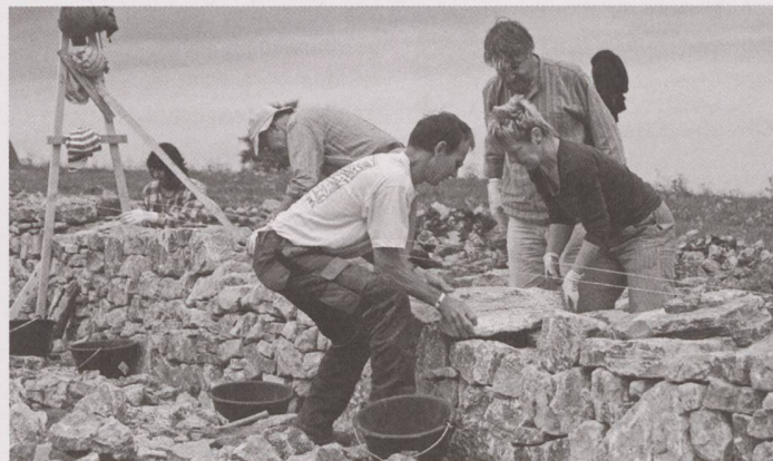
Kein Gramm Mörtel: Trockenmauerbau auf dem Probstenberg (Region Thal).
