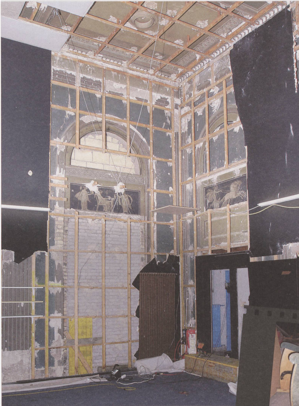
Hintere Raumecke seitlich der Leinwandnische. Ursprüngliche Gestaltung mit antikisierenden Wandbildern hinter Verkleidung der 50er-Jahre auf Holz-Unterkonstruktion.
