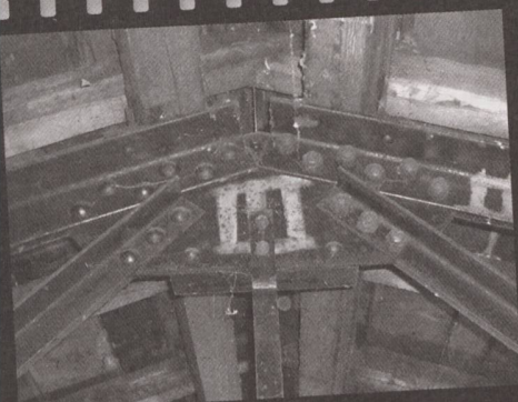
Knotenpunkt eines Stahlfachwerkbinders der Dachkonstruktion mit Abbundzeichen. Deutlich erkennbar sind die Nieten auf der linken, die Schrauben auf der rechten Seite zur Montage des Binders vor Ort.
