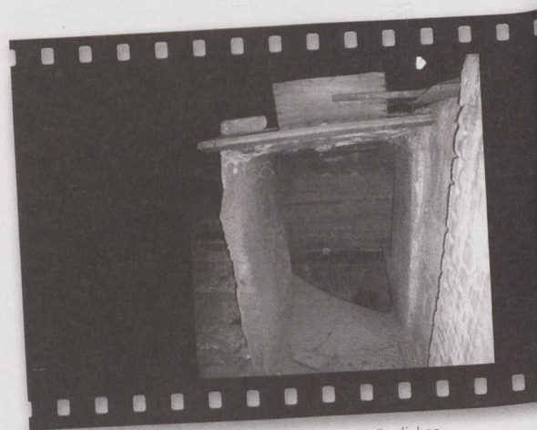
Anschlussstelle des ursprünglichen Lüftungskanals oberhalb der Leinwand.
