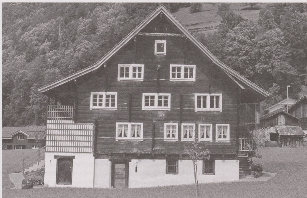
Das Bürgerbauernhaus Balmermatte in Bürglen UR wurde ausgezeichnet für den schonenden, auf dem historischen Bestand fussenden Umbau.
