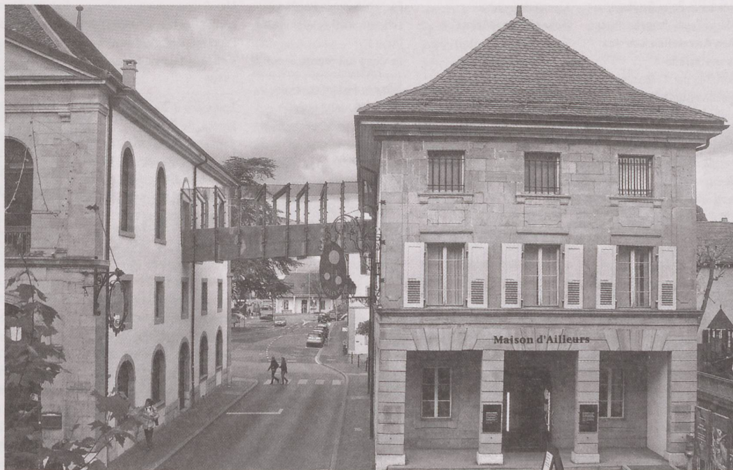
Neues verbindet das Alte: Die Passerelle in der Maison d'Ailleurs weist von aussen auf den neuen Saal im Inneren hin.
