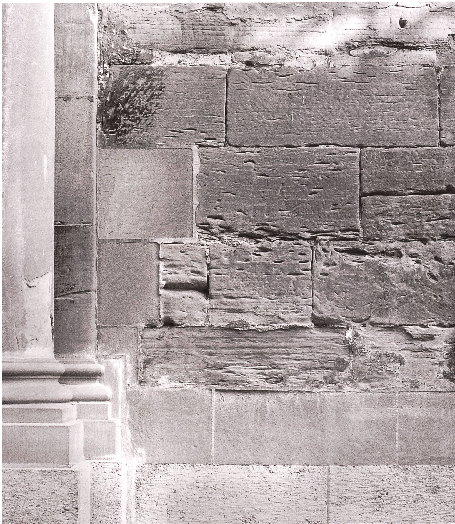
Fribourg, église de St-Maurice, entrée latérale; éléments d'origine dégradés, pièces de remplacement (socle, première assise) insérées au XX e siècle.
