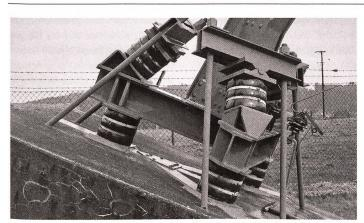
Fuss eines Sendemasts des Mittelwellensenders Sottens (VD).
