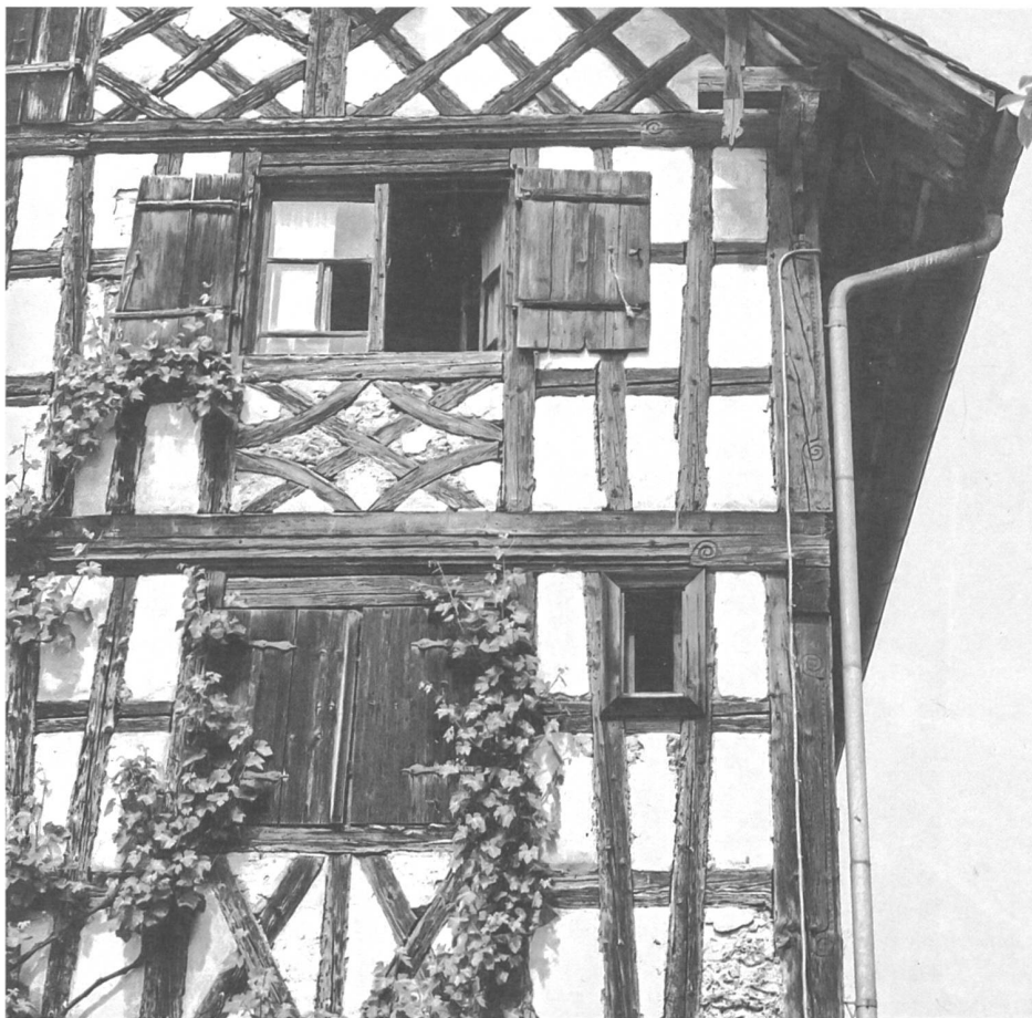
Holzspezifische Eigenschaften können geschickt ausgenutzt werden, so zum Beispiel Krummwuchs für gebogene Streben und Trocknungsverzug für das Einspannen von Fachwerkfüllungen. Bild: Münsterlingen (TG).
