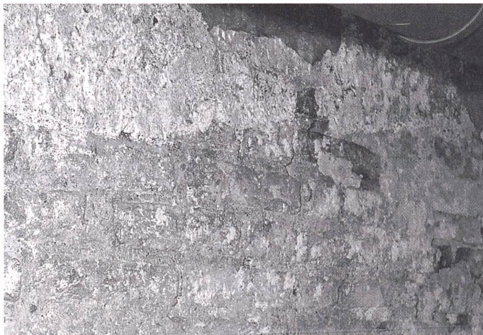
Burgdorf, Wehrturm, unterhalb des Daches, wenig abgenutzte ehemalige Sichtbackstein-Partie.
