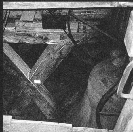
Beffroi de la cathédrale de Fribourg. Tenon et mortaise, assemblage critique entre traverse et filière supérieure.
