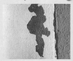
Sanierputze sind hydrophob ausgerüstet und mit einem hohen Anteil an hydraulischen Bindemitteln versehen, meist mit Zement rezeptiert. Die Austrocknung soll über die hohe Dampfdiffusion gewährleistet werden.
