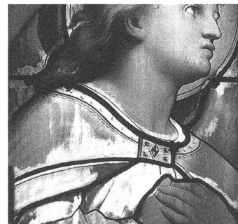
Basel, Elisabethenkirche. Glasmalerei von C. H. Burkhardt, 1865. Schäden der Email-Bemalungen durch Kondensfeuchte.
