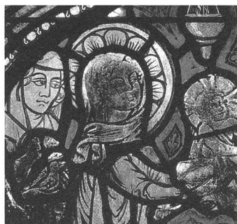
Hauterive (FR), Klosterkirche. Durch Oxydationen im Glas («Verbräunungen») entstellte Glasmalereien des frühen 14. Jahrhunderts.
