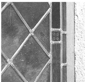
Des Guten zuviel. Neuverbleiung und neue Rahmung einer bewusst an mittelalterlichen Vorbildern orientierten Rautenverglasung von Clement Heaton, um 1900.
