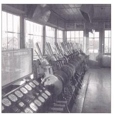
Kerzers - die Hebelbank im Obergeschoss des Stellwerks.
