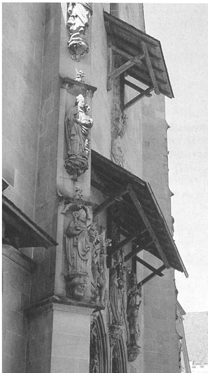
Schutzmassnahmen: Schutzdächer an der Kirche St. Oswald in Zug
