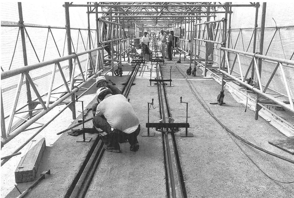
Kornhausbrücke, die neuen Tramgleise werden elastisch im Belag eingebettet. Diese Methode kann nur unter einem Klimadach angewandt werden.
