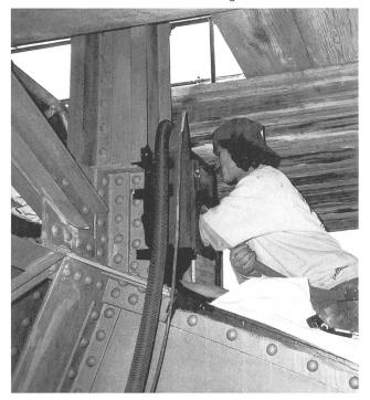
Flussstahl): der grosse Bogen ist 901 Tonnen schwer, die fünf kleinen Bögen mit den beiden Endfeldern wiegen zusammen 913 Tonnen. Die Pfeiler bestehen aus Beton und sind mit Jurakalkstein verkleidet. Der Hauptpfeiler auf dem rechten Aareufer steht auf 432 Hartholzpfählen; alle übrigen Teile sind flach fundiert.
