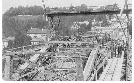
deutlich hervor: die Tragkonstruktion war der ständig wachsenden Verkehrsbelastung je länger je weniger gewachsen. Am Stahl, an den Betonummantelungen der Tramschienen, an den Abdichtungen und am Belag traten laufend neue Schäden auf.
