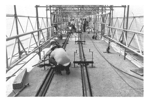
Kornhausbrücke, die neuen Tramgleise werden elastisch im Belag eingebettet. Diese Methode kann nur unter einem Klimadach angewandt werden.
