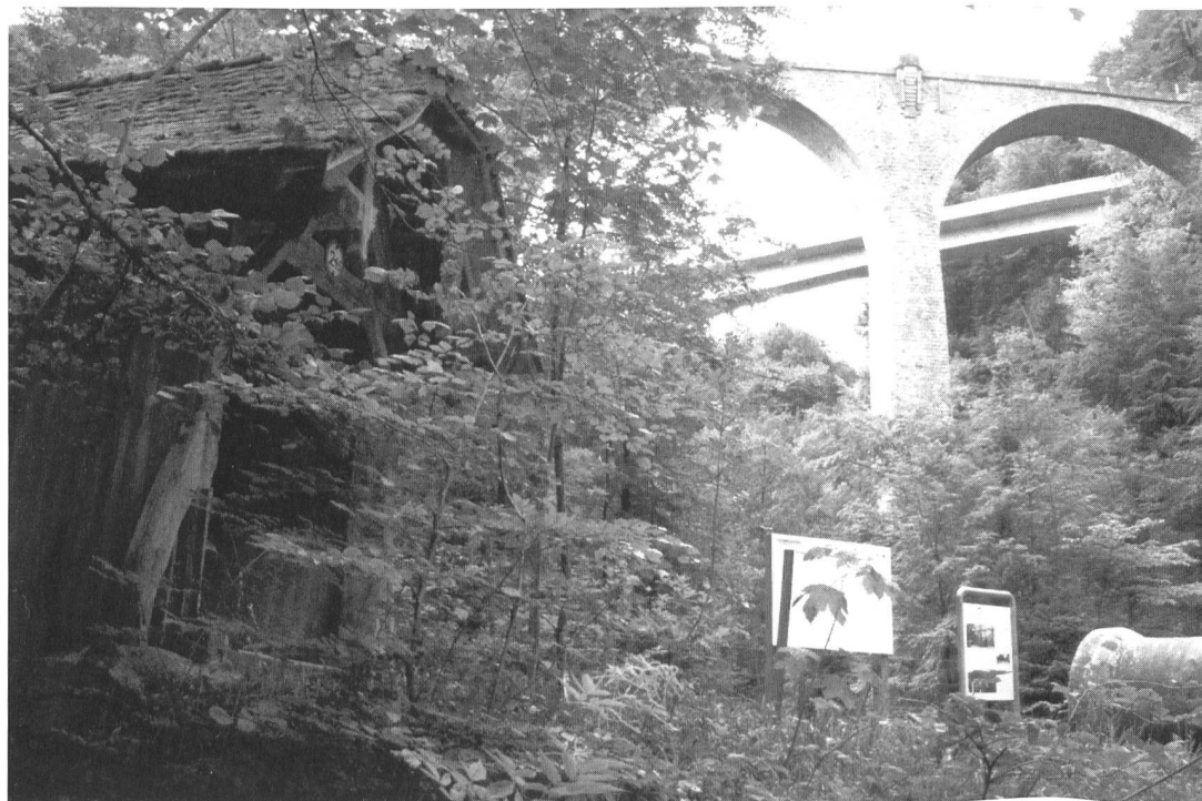
Drei Brücken aus verschiedenen Zeiten überspannen das Lorzetobel bei Zug auf unterschiedlicher Höhe: die Holzbrücke der alten Landstrasse von 1759, das rund 60 m hohe Bogenviadukt von 1910 und die aktuelle Betonbrücke von 1985.
