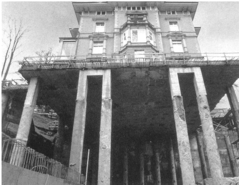
Zürich: beim Bau der sogenannten Ami-Klinik wurde ein Teil der ursprünglichen Bau- substanz «unterhöhlt» (Bernhard Furrer)
