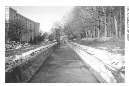
Le canal pendant les travaux, le treillis d'armature est posé contre les parois latérales
