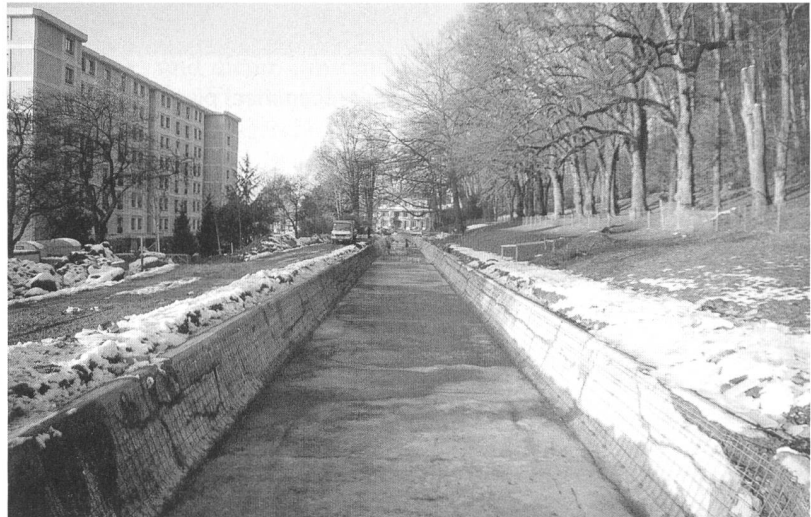
Le canal pendant les travaux, le treillis d'armature est posé contre les parois latérales
