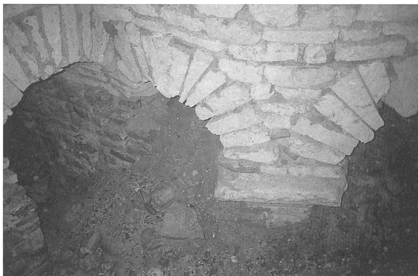
Augusta Raurica: Kleine Bogenkonstruktionen stützen das unterirdische Gewölbesystem ab
