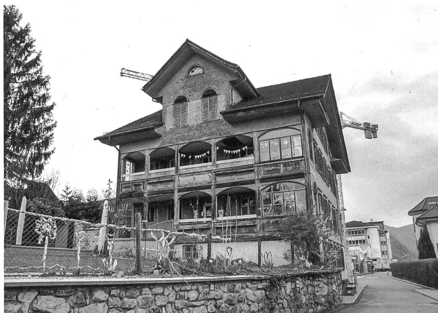
15.4. Das Keyserhaus an der Nägeligasse in Stans wird saniert.
