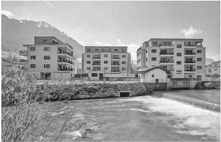
19.11. Überbauung «Am Aawasser» Buochs, mit Wasserkraftwerk.
