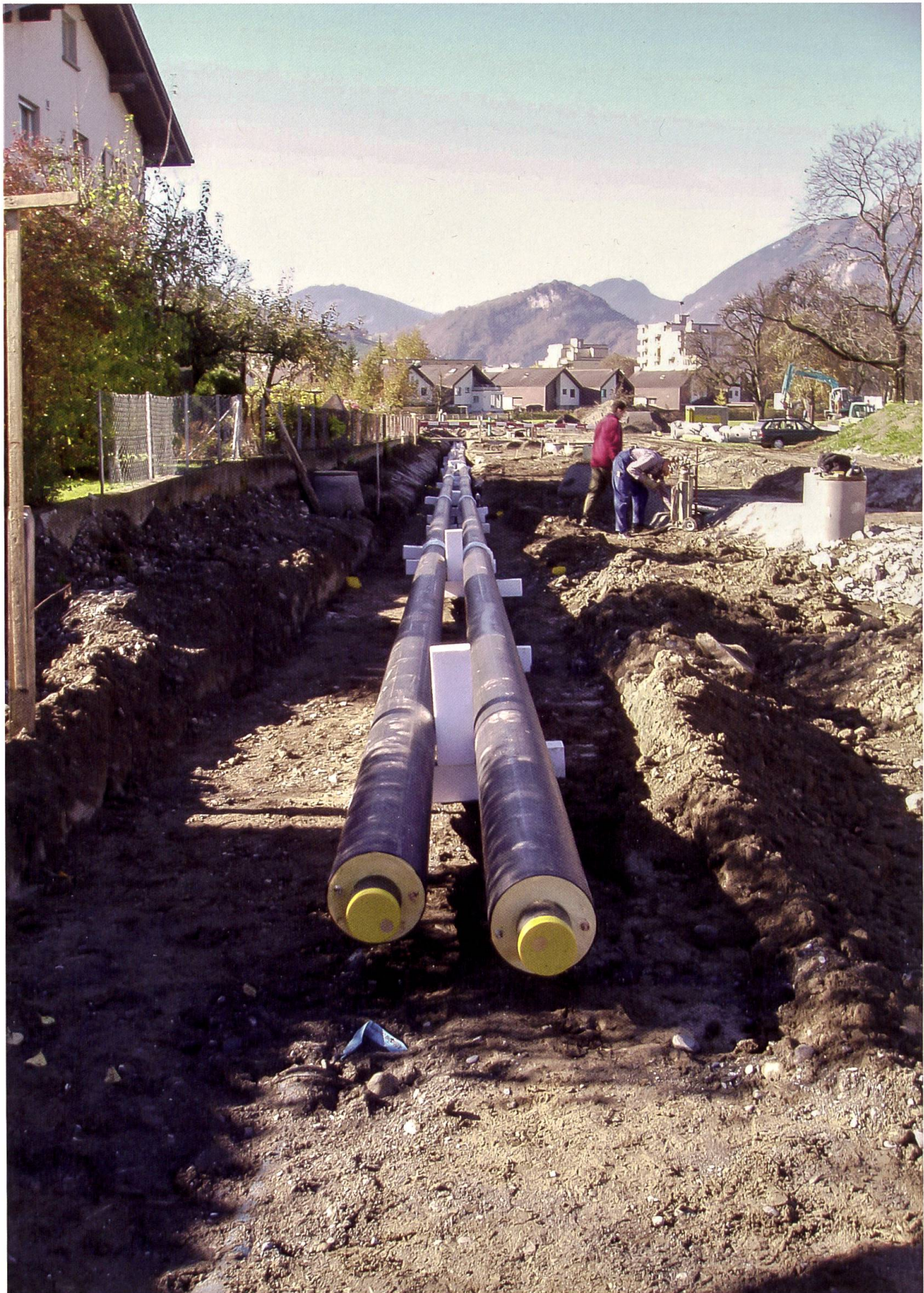
Mini-Pipeline: Das eine gut isolierte Rohr liefert heisses Wasser, das andere fñhrt das abgekñhlte Wasser zurñck.
