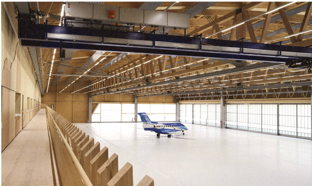
Die 2017 in Betrieb genommene, stützenfreie Halle 25 der Pilatus-Flugzeugwerke in Stans ist eine holzbautechnische Meisterleistung aus einheimischem Holz.
