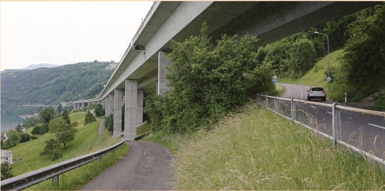
Einem Tatzelwurm gleich schlängelt sich der Lehnenviadukt zum Seelisbergtunnel.
