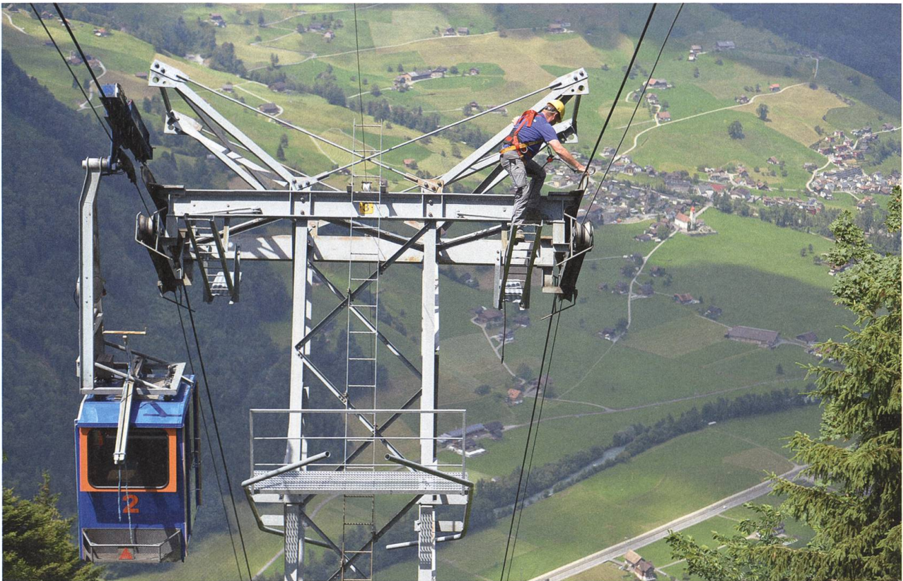
Auf die Masten steigen gehört zur guten Wartung, wie hier bei der Luftseilbahn Zegli-Brändlen.
