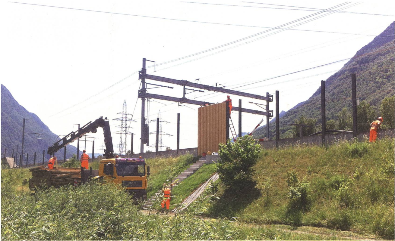
Einzelmontage der Elemente: Direkt ab dem Sattelschlepper zur Lärmschutzwand geformt.
