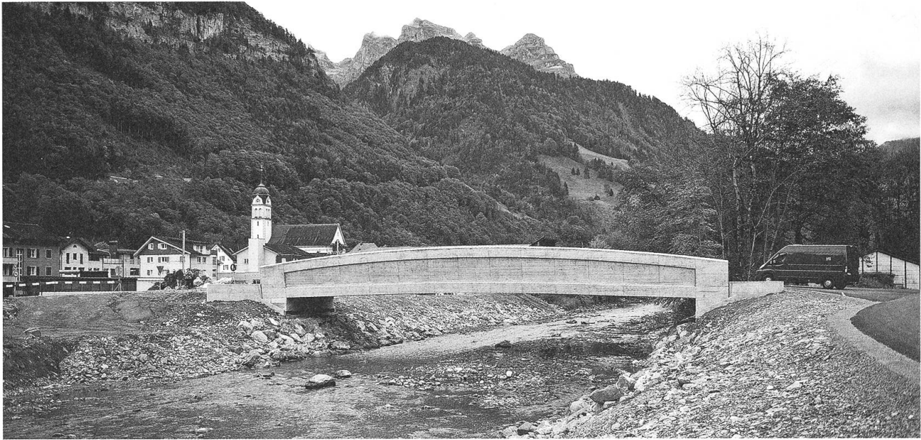
15.10. Die neue Oberaubrücke ist besser geschützt gegen Hochwasser als ihre Vorgängerin aus Holz.
