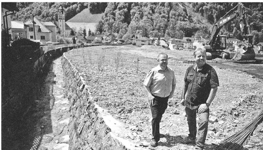
16.5. Humligenbach: Das letzte Hochwasserschutz-Projekt abgeschlossen.
