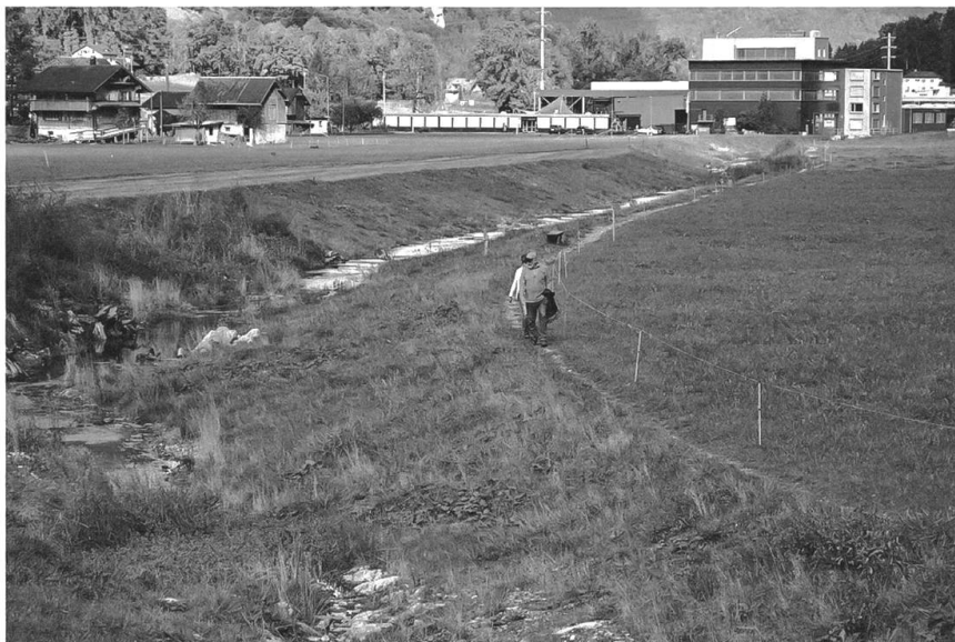
14.10. Lochrütibach: Hochwasserschutz und Naherholungsgebiet.
