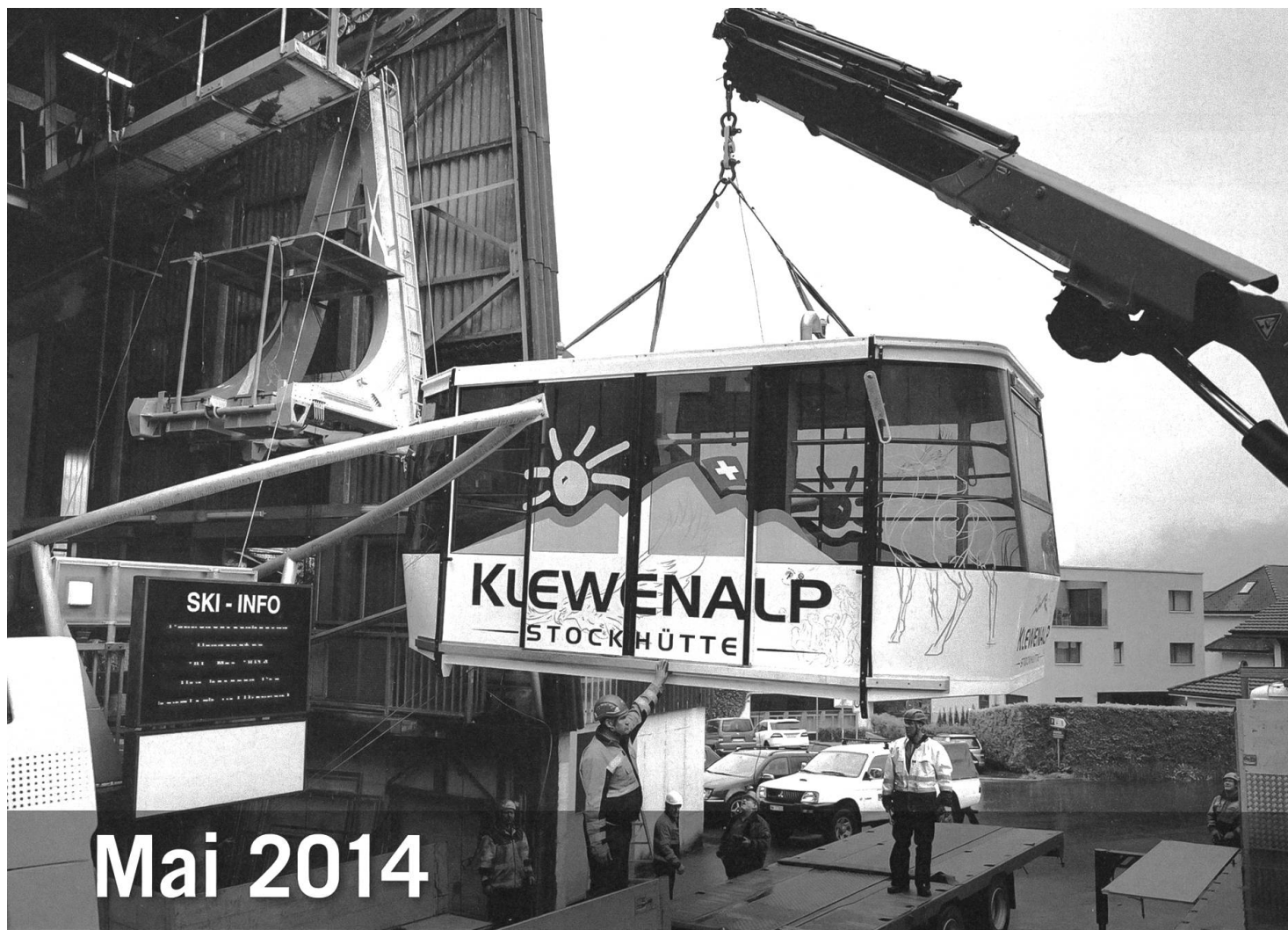
7.5. Bei der Klewenalp-Bahn hat man im Zusammenhang mit der Konzessions-Verlängerung entschieden, nicht nur Motor und Steuerung zu erneuern, sondern auch die 42-jährigen Kabinen zu ersetzen.
