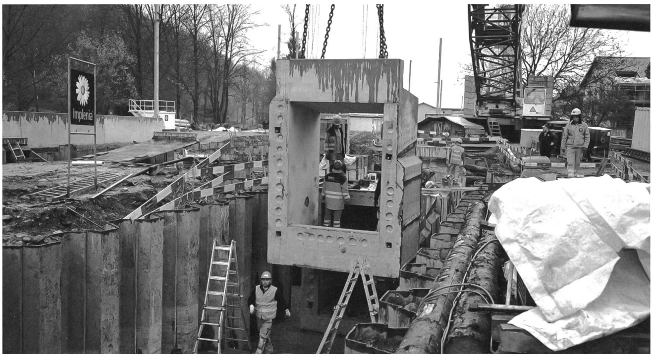
22.11. Hier entsteht der neue Bahnhof Wolfenschiessen.
