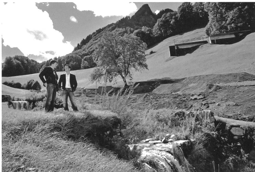
21.9. Der Träschlibach oberhalb Beckenried muss saniert werden.
