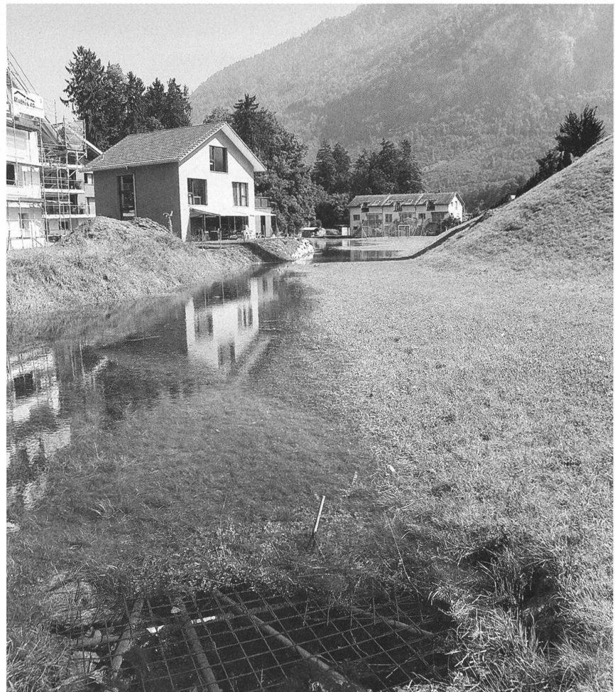
10.9. Der Bruderhausbach soll aus seinem Korsett befreit werden.
