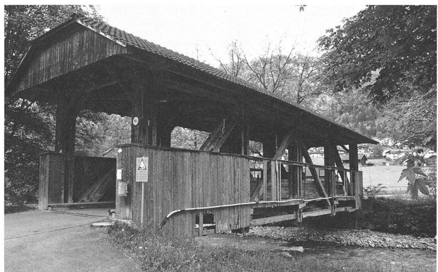
24.5. Die Oberaubrücke wird für 1,8 Millionen Franken erneuert.
