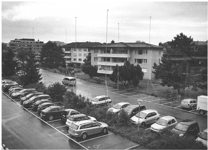
13.8. Standort der neuen Alterswohnsiedlung beim Bahnhof Stansstad.
