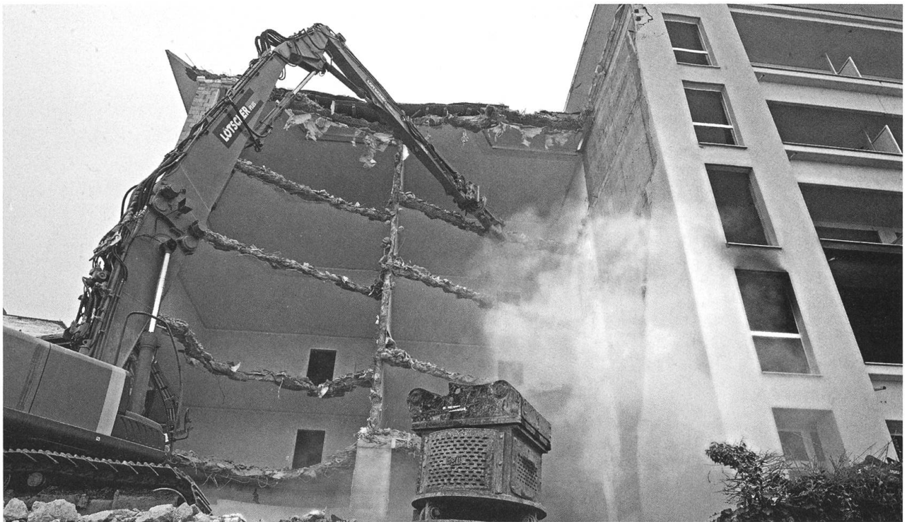
24.1. Gnadenlos zerlegen schwere Baumaschinen das alte Park Hotel.
