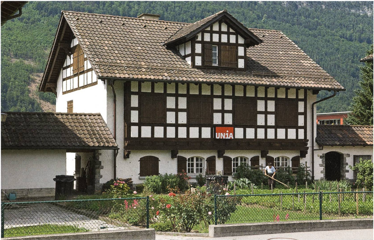
Die SMUV-Siedlung in Stans ist nach einem Vorbild der Landi 1939 gestaltet.
