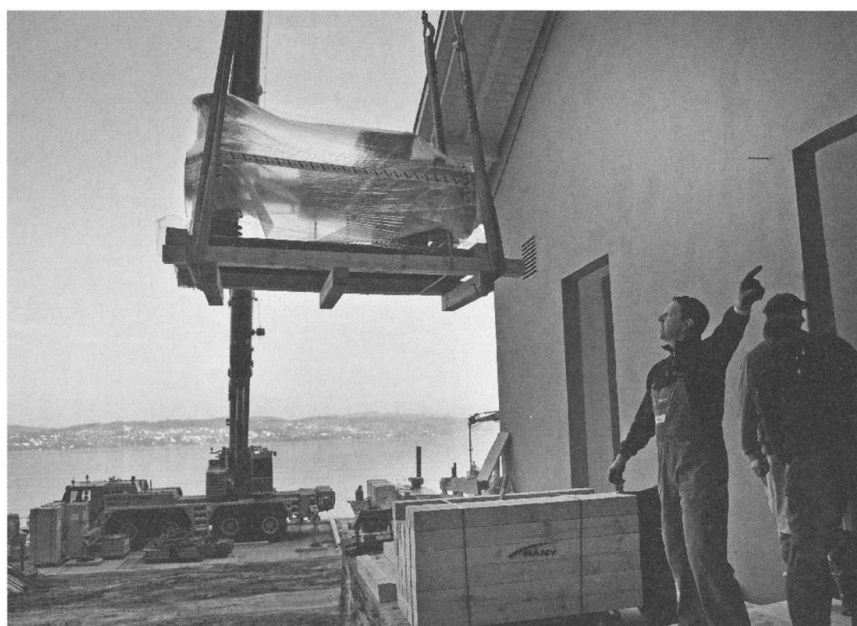
27.3. Ein riesiger Pneukran hievt die Pumpen vom See ans Ufer bei der Pumpstation.
