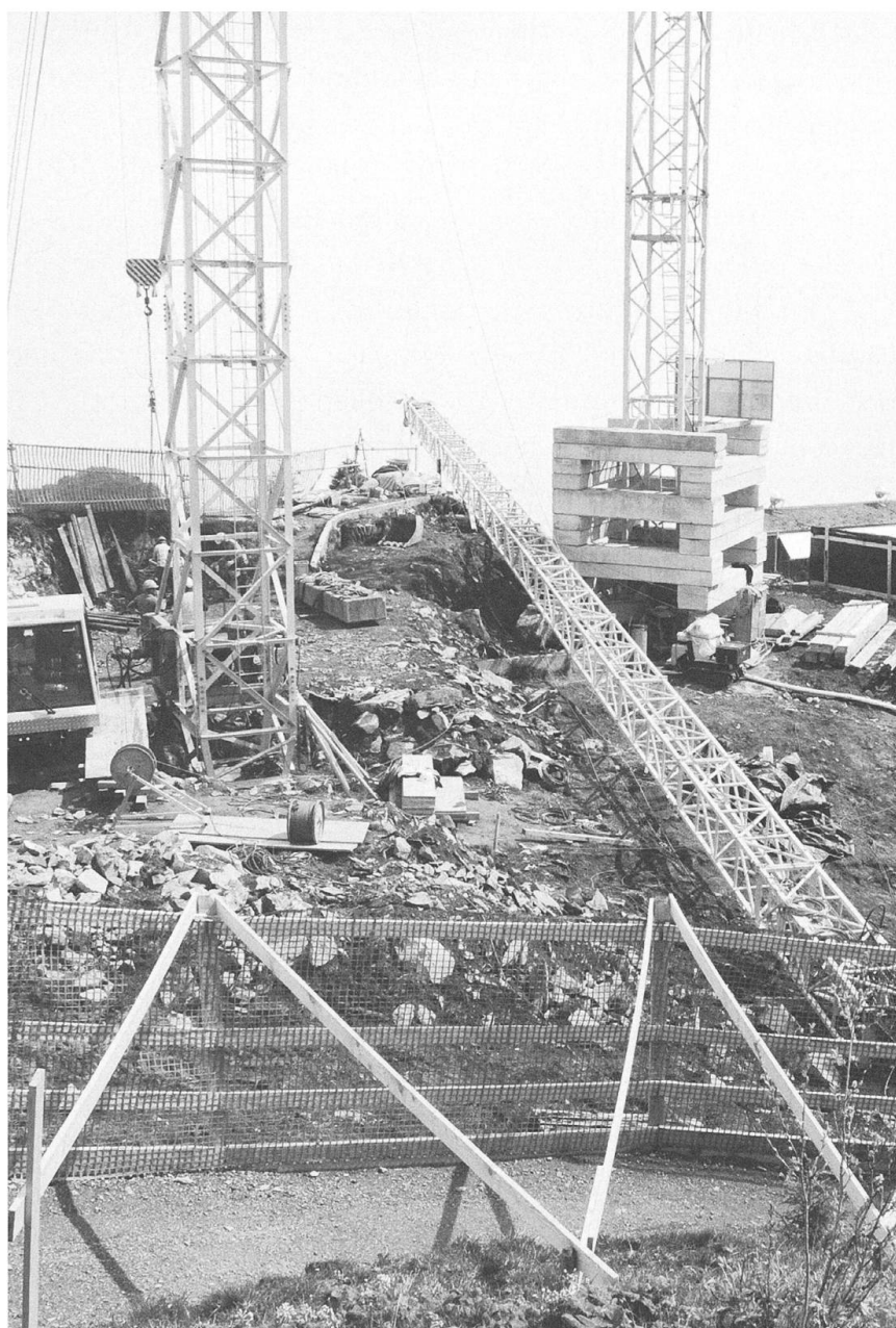
23.5. Baubeginn der Bergstation.
