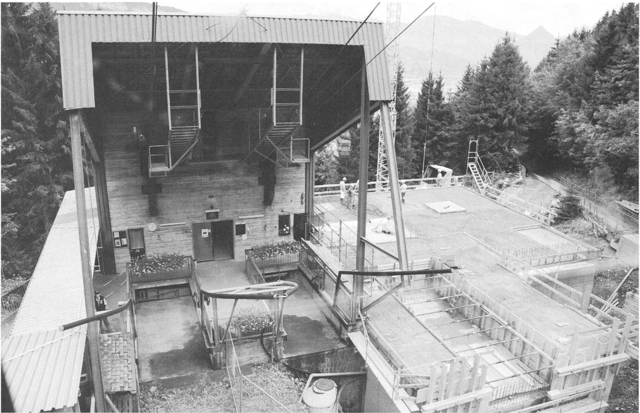
4.8. Neben der heutigen entsteht ein Teil der neuen Talstation der Stanserhorn-Bahn.
