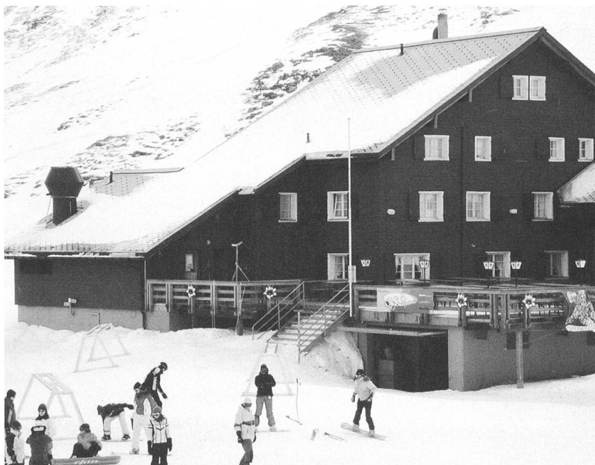
27.1. Auf dem Jochpass entsteht ein Teilneubau.
