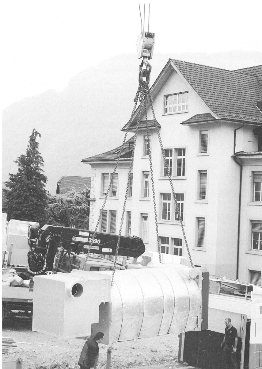
29.4. Heizverbund untere Kniri: Heizkessleinbau.
