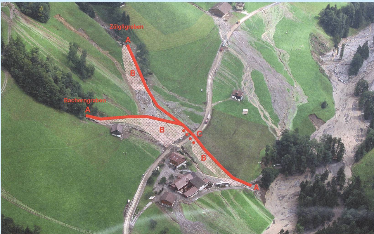
Das heutige Schutzsystem Schürmatt, eingezeichnet in eine Luftaufnahme nach dem Unwetter 2005.
