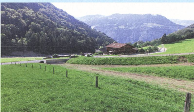
B: Die Zufahrtsstrasse zum Gaden wirkt als Damm gegen das zusammengeführte Wasser.
