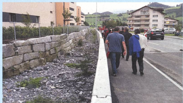
H: Die Versickerungsmulde leitet zugleich das Hochwasser weiter ins Retentionsbecken.
