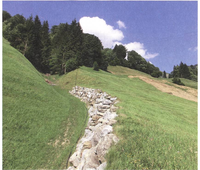
Ein Wildbach zerstörte beim Unwetter 2005 die Scheune des Hofes Schiltli in Oberriickenbach total (links). Heute wird Damm gefasst (Mitte) und an der wieder aufgebauten Scheune vorbei geführt, ohne Schaden anzurichten (rechts).
