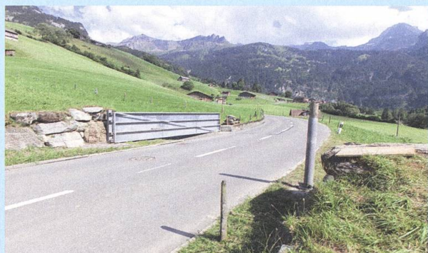
C: Wird das Tor geöffnet, fließen die Wildbäche über die Strasse Richtung Secklisbach.
