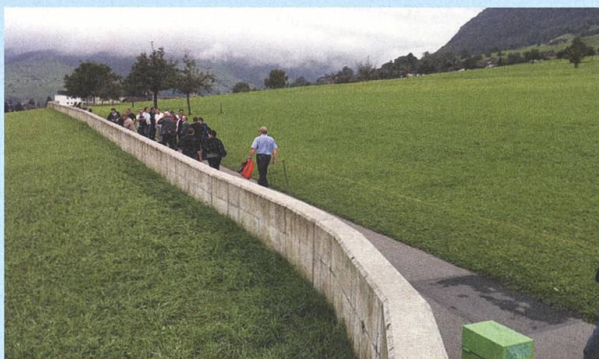
E: Die Mauer verhindert, dass Wasser ins Spital dringt. Es fließt entlang der Mauer ab.
