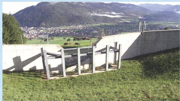
A: Der Geschiebesammler hält Steine und Stämme auf und bremst das Fliesstempo des Wassers.
