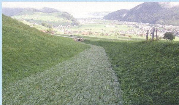
B: Das landwirtschaftlich nutzbare Abflussgerinne mit Strassen-Unterquerung.
