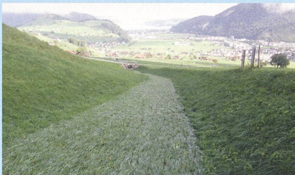
B: Das landwirtschaftlich nutzbare Abflussgerinne mit Strassen-Unterquerung.
