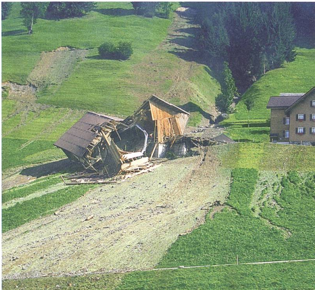
Ein Wildbach zerstörte beim Unwetter 2005 die Scheune des Hofes Schiltli in Oberriedenbach total (links). Heute wird Damm gefasst (Mitte) und an der wieder aufgebauten Scheune vorbei geführt, ohne Schaden anzurichten (rechts).
