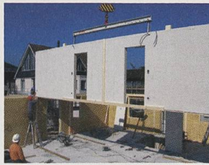
Innert wenigen Tagen sind die Systembauteile montiert.
