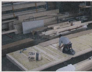
Wärmedämmung in unserer Produktionshalle.
